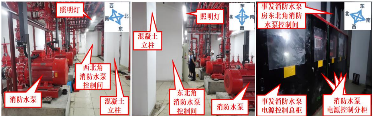
图 5 事发消防水泵房和水泵控制间内实景图
